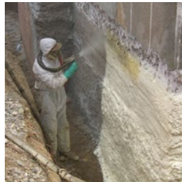
4. Spruzzo di schiuma (Applicazione controterra PUR)
