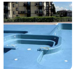
6. Rivestimento a spruzzo (applicazione Poliurea)
