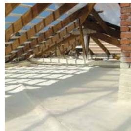
5. Spruzzo di schiuma (applicazione sottotetto PUR)
